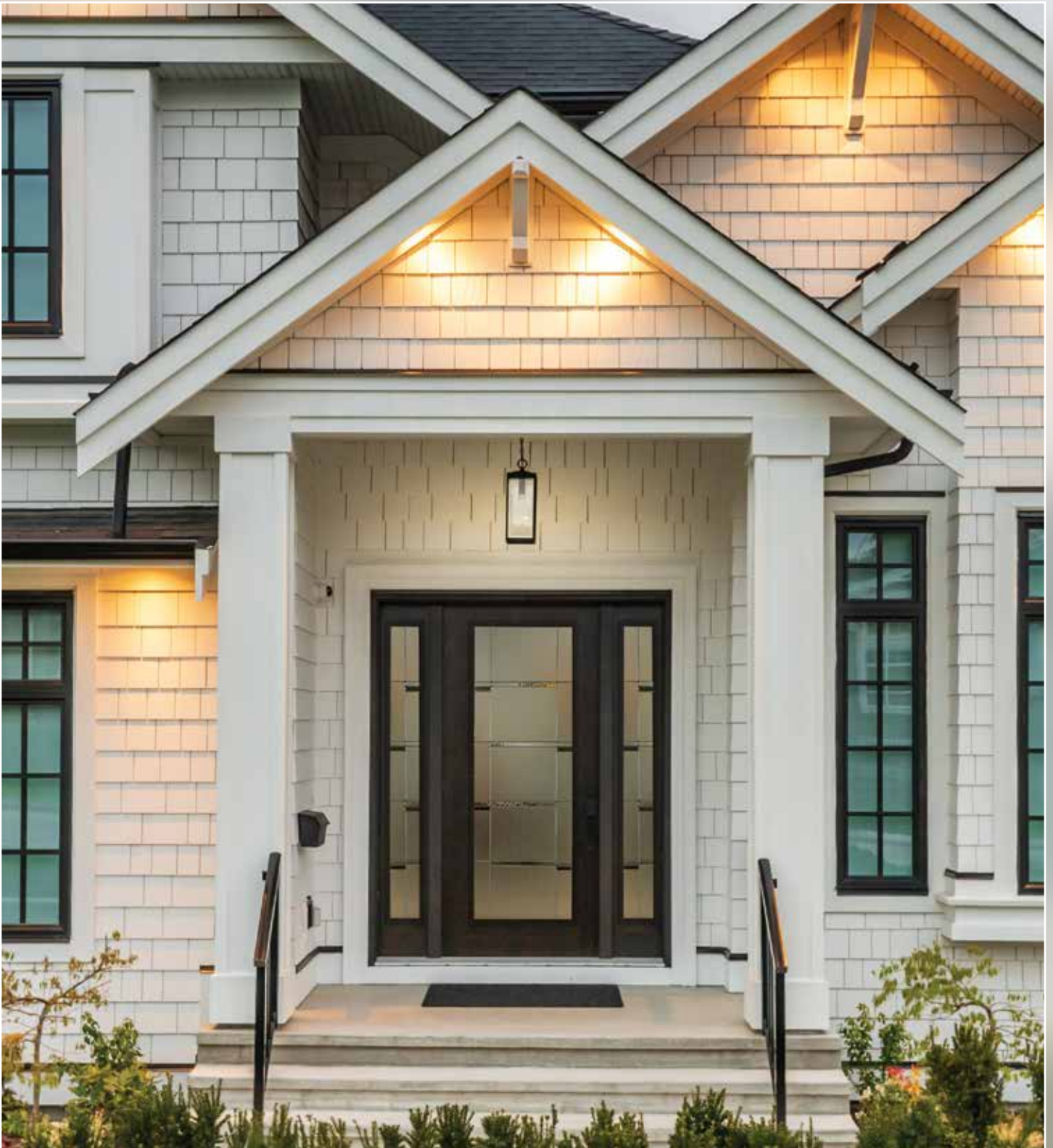
EXTERIOR DOOR OVERVIEW
